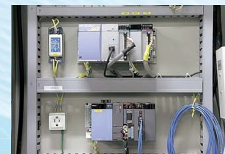
圧縮機遠隔監視システムは運転モニター付きの台数制御盤
