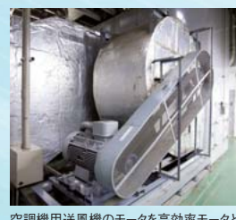
空調機用送風機のモータを高効率モータとインバータ盤との組み合わせ制御に更新
