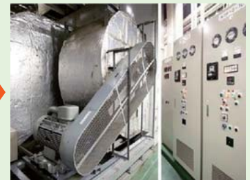
改修後 (モータ部と制御盤)
