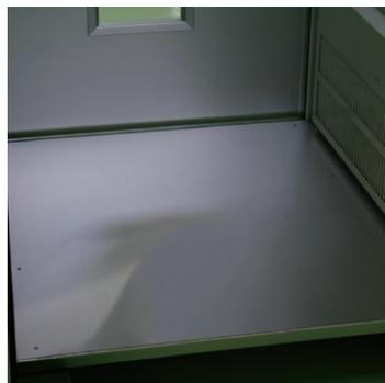
標準品は建屋の床を使用しますが、SUS（ステンレス）床を取付け可能です。（バリデーション対応型はSUS床標準装備）
