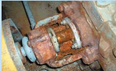
経年劣化により腐食、水漏れしたポンプ
