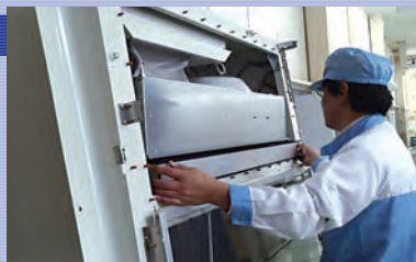
HEPAフィルタ交換
