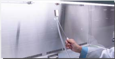
HEPA フィルタ 透過率 測定
